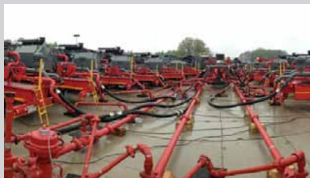
Трубная обвязка флота ГРП
