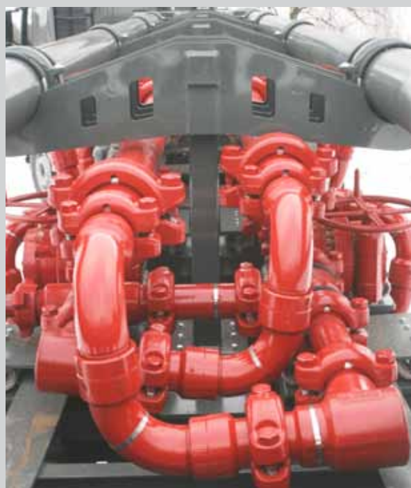
Линии высокого давления диаметром 4"
